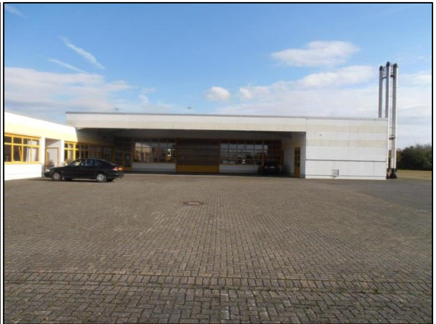
Entree opslagruimte / werkplaats
