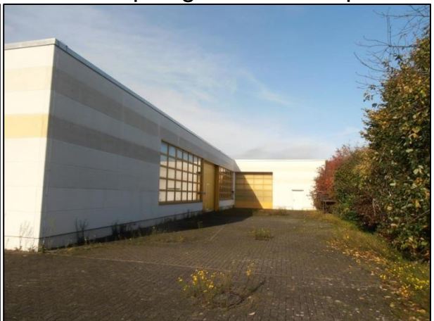
Achterzijde met poorten
